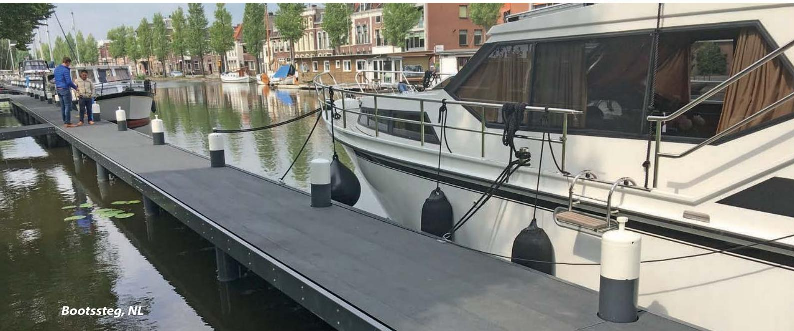
**Ein herkömmliches Holzdeck ist aufgrund der neuen Bestimmungen (FSC Zertifizierungen und ähnliches) und der aufwendigen Montage und Beschichtung annähernd preisgleich mit einem GFK-Deck. Und das ohne Berücksichtigung von den weiteren GFK Vorteilen, wie Wartungsfreiheit und Rutschsicherheit.**
